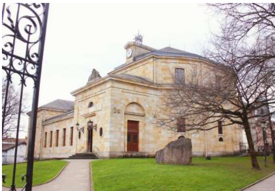
Casa de Juntas en Gernika
